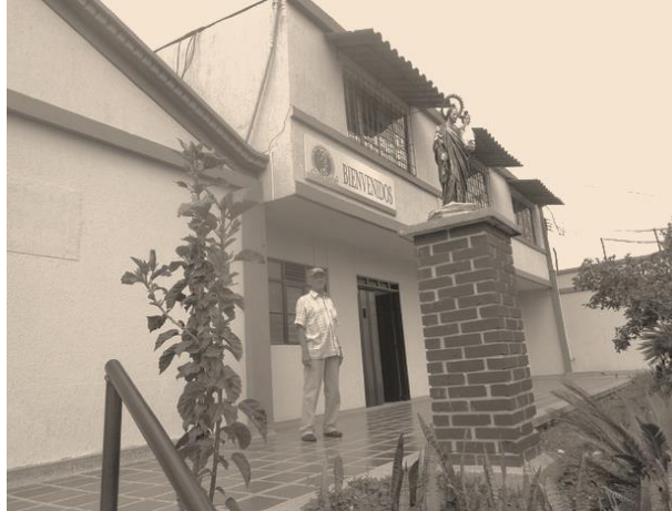
Ilustración 1. Fachada del centro de bienestar del
