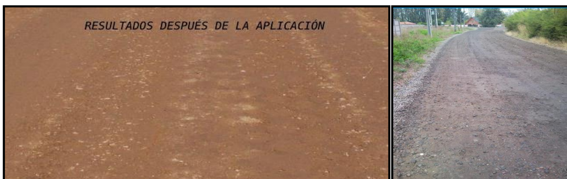
Imagen 27. Resultados de la aplicación de supresor de polvo
