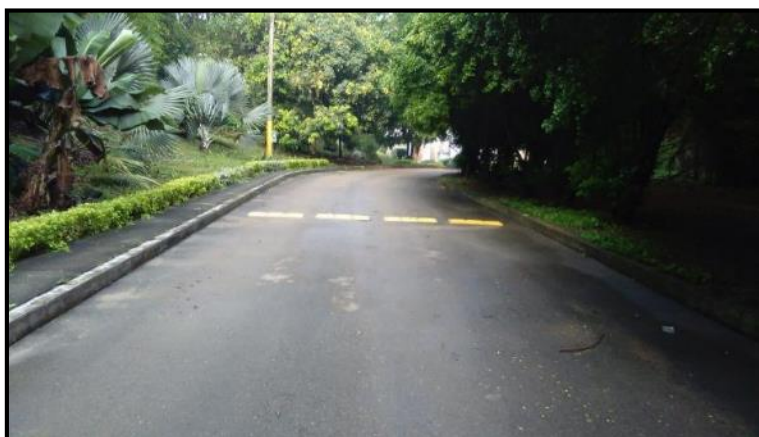
Imagen 10. Reductores de velocidad instalados
