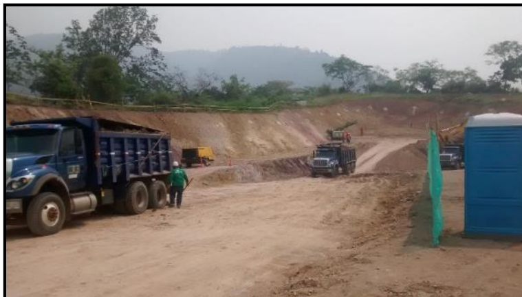
Imagen 3. Área de intervención para la construcción de la PTAP Los Angelinos
