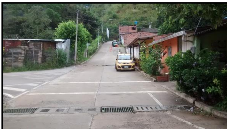
Imagen 1. Vía Barrio Bosconia (Calle 40)
