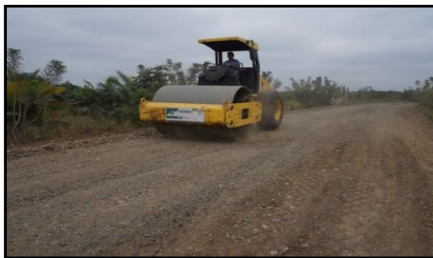
Imagen 24. Compactación de la vía
