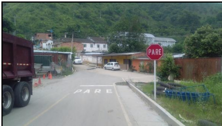
Imagen 8. Señalización vertical y de piso instalada en el Barrio Bosconia
