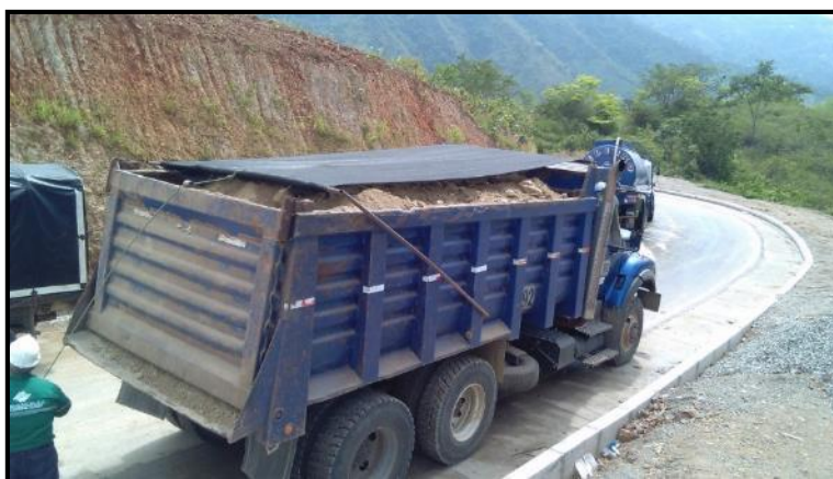
Imagen 12. Carpado de volquetas en la salida del frente de obra principal
