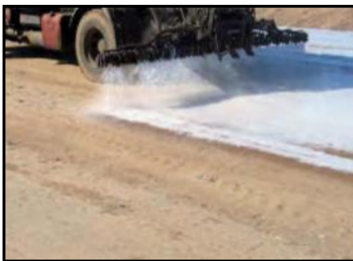
Imagen 25. Irrigación de la vía con carro tanque
