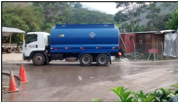
Imagen 19. Riego de vías pavimentadas (pavimento rígido y pavimento flexible) – Barrio Bosconia
