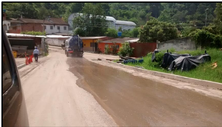
Imagen 17. Riego en vías pavimentadas (Pavimento rígido y flexible) – Barrio Bosconia
