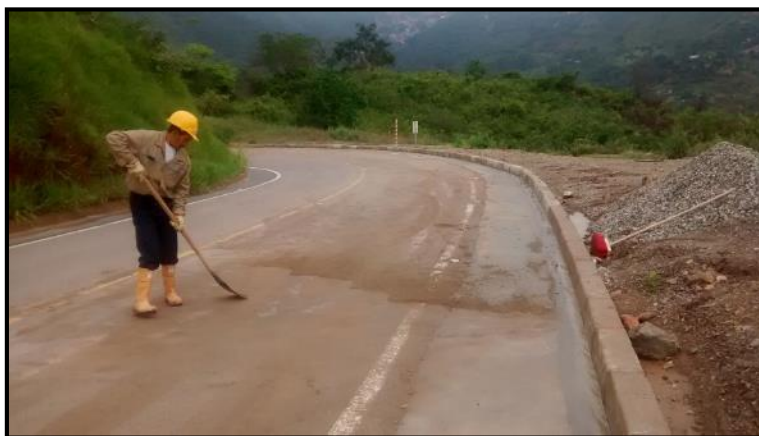
Imagen 14. Limpieza de vía – Vereda Los Angelinos
