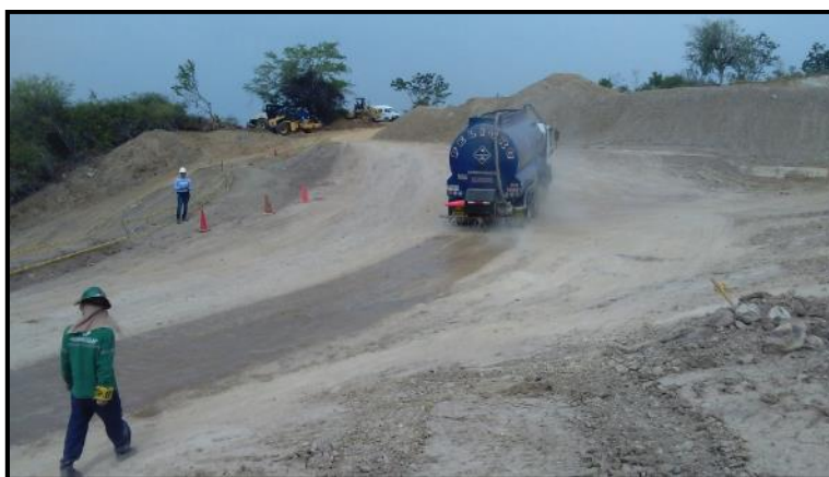
Imagen 20. Riego de vías sin pavimentar (PTAP Los Angelinos) – Vereda Los Angelinos
