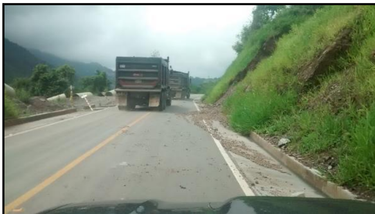
Imagen 4. Circulación vehicular en el acceso a la PTAP Los Angelinos
