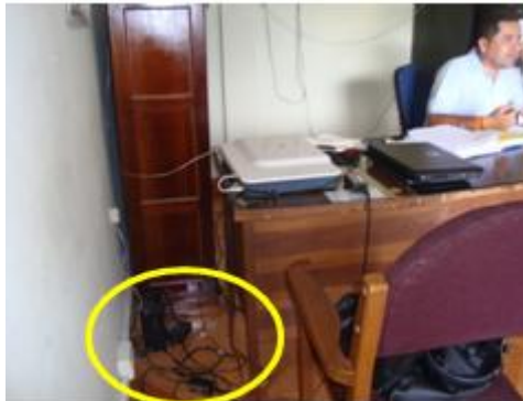
Figura 20. Cable sin canaletas
