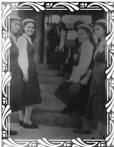
Fotografía 6: El uniforme escolar del Colegio Labouré. Santa Rosa de Cabal, año 1956.
