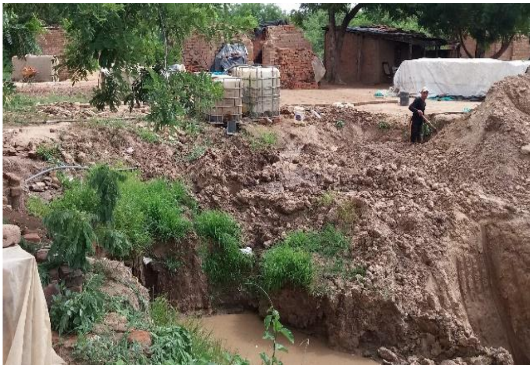
Anexo 4 Evidencia fotográfica de la cantera Las Casitas.
