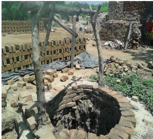
Ilustración 14. Pozos de agua sin proteccion
