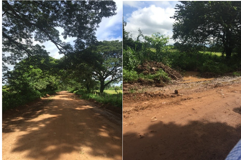
Figura 2. Mantenimiento preventivo sobre la vía en el corregimiento de Casacará
