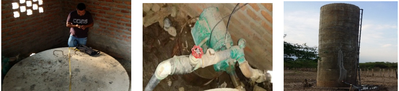
Figura 21. Toma de Datos en Campo del Inventario de Agua Subterránea en propiedad Buenos Aires
