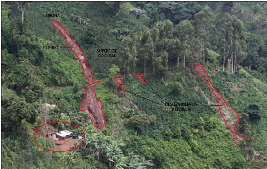
Figura 13. Deslizamiento traslacional vereda Las Nubes.
