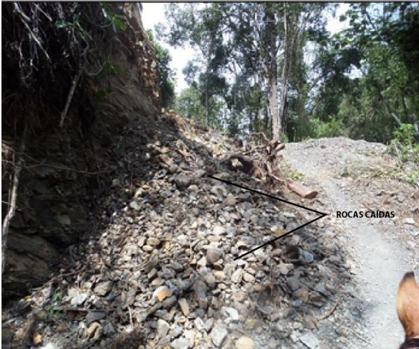
Figura 16. Caída de rocas, vereda Alto el Riecito.
