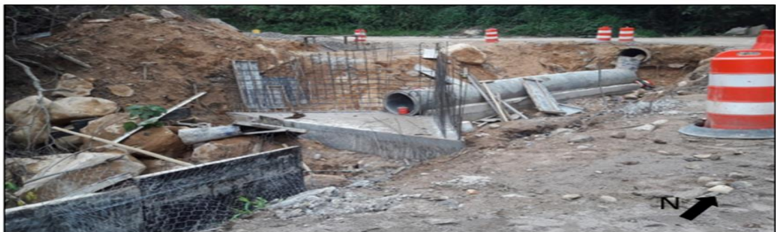
Figura 41. Instalación de acueductos y redes de drenaje en el kilómetro 10 de la vía.
