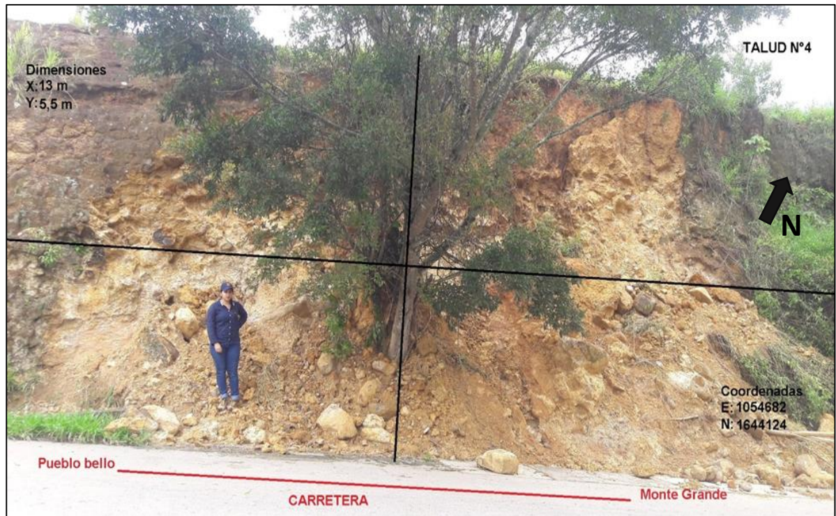
Figura 34. Estación 20, Talud 4 en la sectorización muestral taludes.
