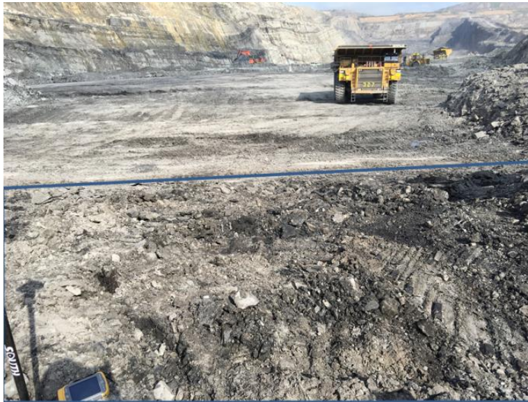
Fotografía 3: Techo sano del manto 330.
