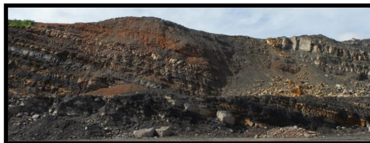
Imagen 8. Aspecto general del talud presente en bloque 6. Ubicación E.
