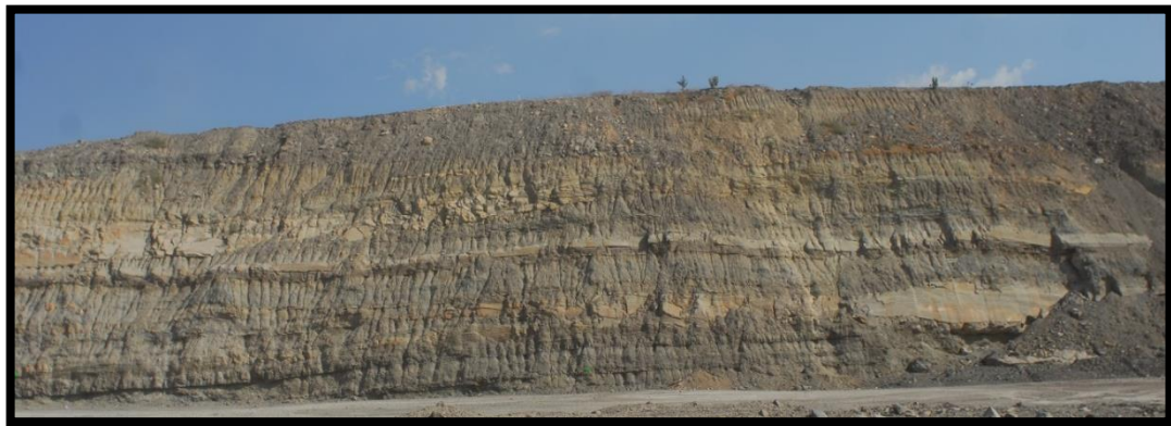
Imagen 9. Aspecto general del talud presente en bloque 6. Ubicación W.
