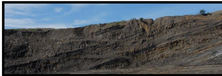
Imagen 7. Aspecto general del talud presente en bloque 6. Ubicación W.
