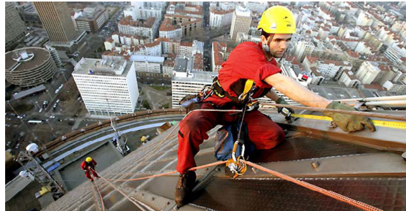
Imagen 6. Trabajo en alturas.
