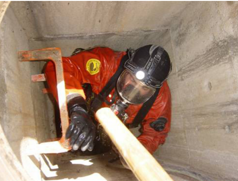
Imagen 5. Trabajo en espacios confinados.
