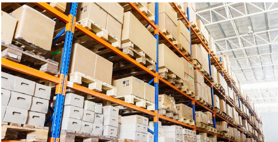
Figura 2. Sistema típico de almacenamiento mediante la utilización de estantería sin pasillos y la utilización de equipos de mantenimiento Fuente: Shutterstock/127809008
