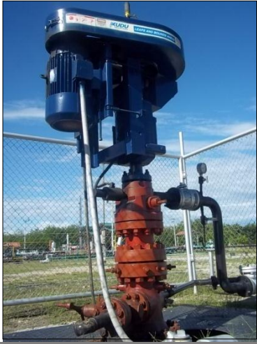
LEVANTAMIENTO PCP, ESP y BOMBEO MECÁNICO
