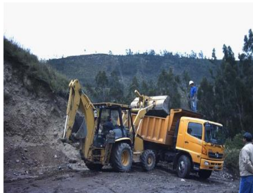
Figura 6. Mina Tibamoa transporte de material de cantera.
