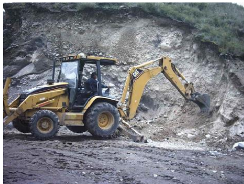
Figura 5. Mina Tibamoa arranque con maquinaria
