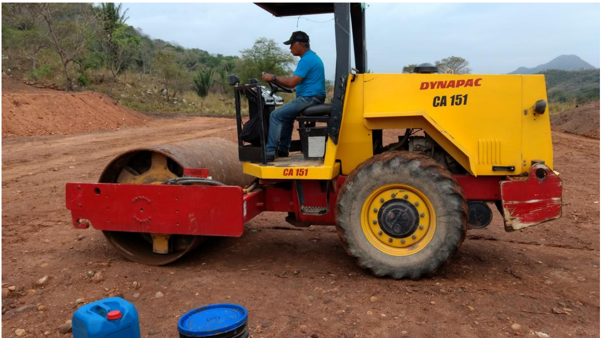
Foto 6. Vibro compactador del proyecto minero, Arreglo de vías
